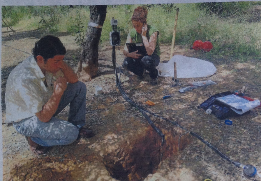
Dos técnicos instalan el sistema en el suelo del cultivo.
